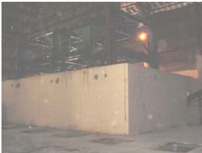
Anexo N°10. Ubicación dentro de la Sala de Control.
