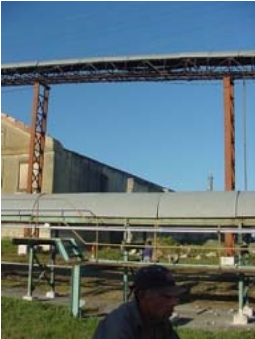
Anexo N°6. Conductor N°22.
